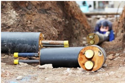
**Bildunterschrift:** Die Rohre für Wärmenetze sind besonders gut isoliert. So geht auf dem Weg zum Kunden wenig Wärme verloren. Energieträger sind oft erneuerbare Energien und Wärme aus Kraft-Wärme-Kopplung. (Bild: KEA)
