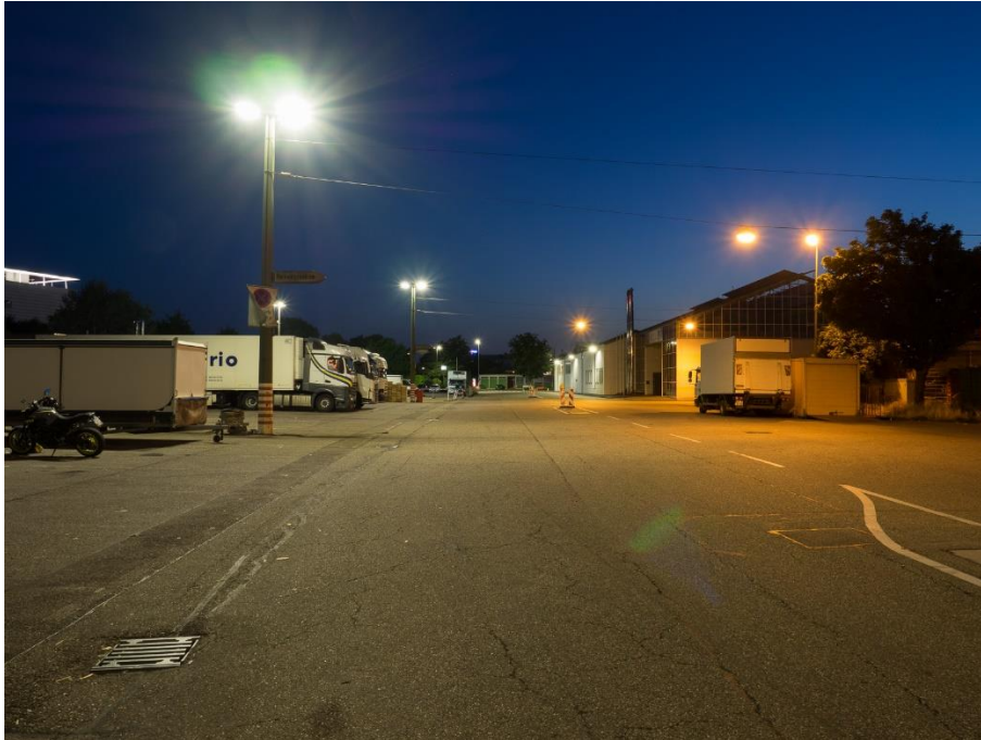
Die neue LED-Beleuchtung des Großmarktgeländes (Manfred Weiß, Stadtwerke Karlsruhe)
