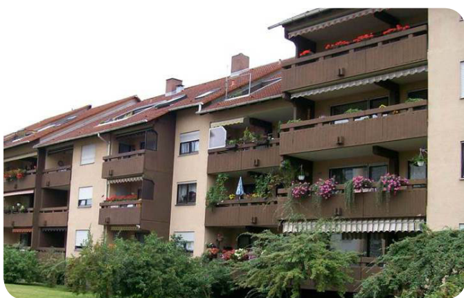
Das Gebäude vor der Sanierung...
