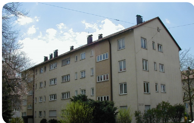
Das Gebäude vor der Sanierung...
