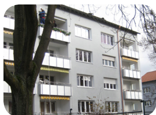
Die Rückseite nach der Sanierung
