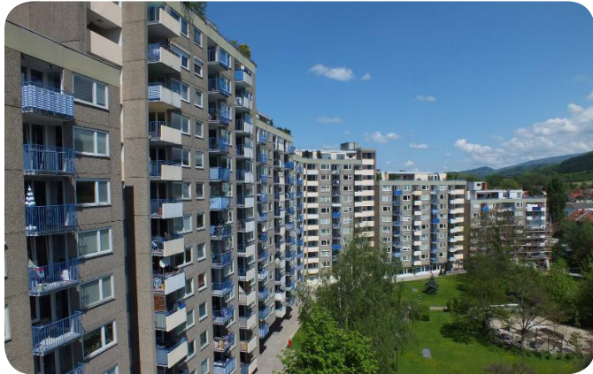
Die Waschbetonfassade vor der Sanierung.
