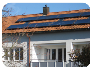
Das runderneuerte Dach
